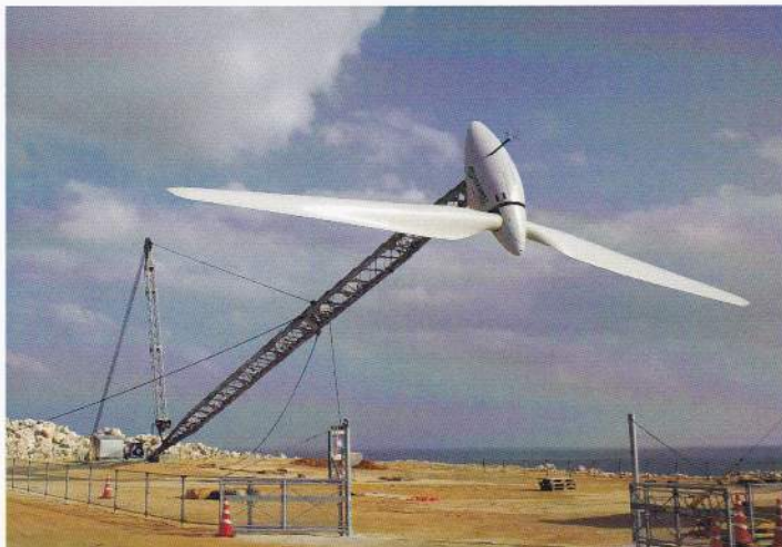
風車の傾倒作業
