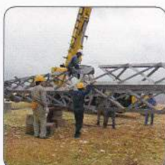
タワーの組み立て
