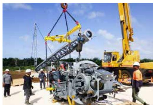
可倒式風車 ナセル組立風景(トンガ)
