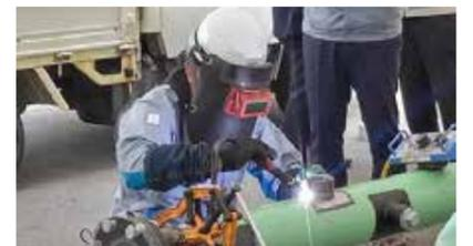
ガス管緊急補修に関する訓練
