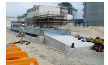
LNG出荷設備の建設 [計量器（トラックスケール）設置状況]
