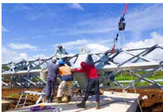
可倒式風車 タワー連結作業風景(トンガ)
