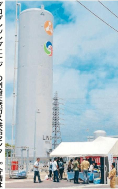
された。液化天然ガス（LNG）をためる槽は高さ16m、容量100キロリットルで、約44トンのLNGを貯蔵できる。LNGは沖縄電力吉の浦火力発電所から、8トンのローリー車で供給センターへ移送される。気化器や付臭設備を経て工場内の炉の燃料として利用されている。非常用発電機も備えて、停電しても3日は製造を続けられるという。総工費は約2億円で、県から5千万円の補助金を受けた。
