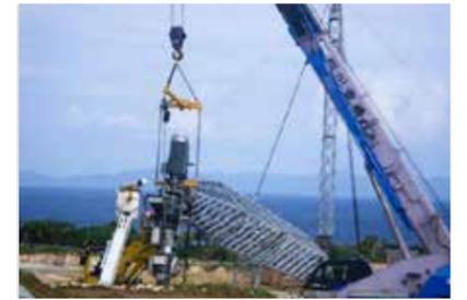
タワーへのナセル取付作業
