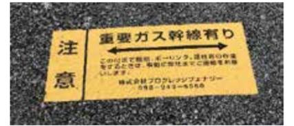
ガス導管敷設明示ステッカー
