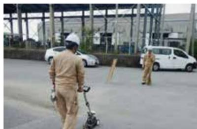
定期的な埋設ガス導管漏洩検査
