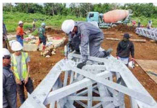
可倒式風車 タワー地上組立風景(トンガ)
