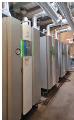
最新の高効率ボイラに更新
