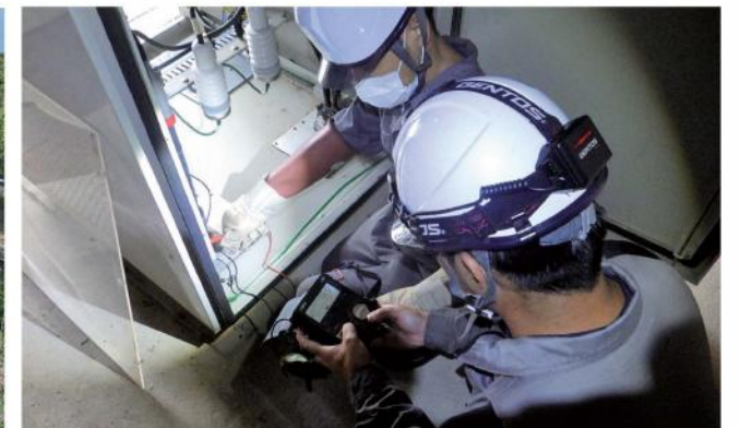
▲作業風景(受電設備点検)
