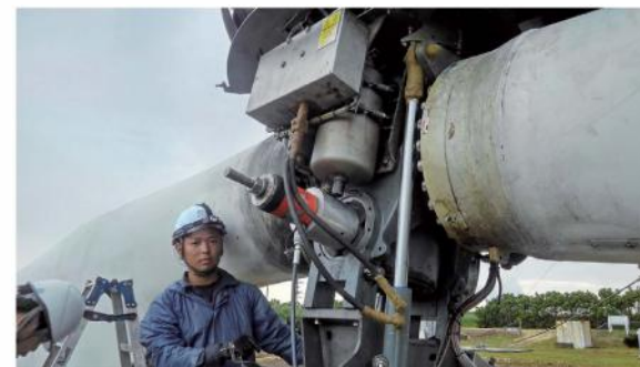
▲波照間可倒式風車補修作業
