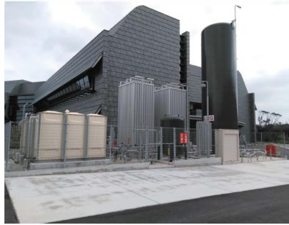
▲LNGサテライト及び第4研究棟
