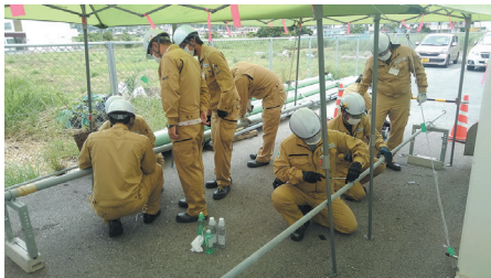
▲漏洩処置作業の様子
