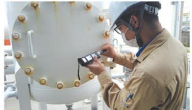
▲日常点検作業(ガス漏洩検査)
