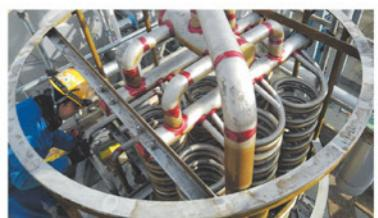
▲年次自主検査作業(気化器解放検査)
