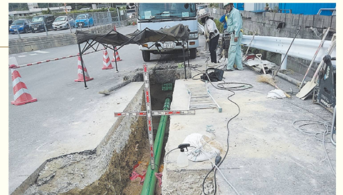
▲中城村内ガス導管延長工事の様子
