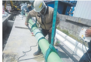
▲中城村内ガス導管延長工事の様子
