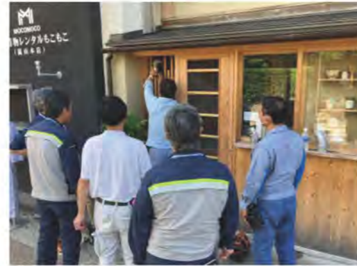
▲給湯器の給排気不良改善工事の様子
